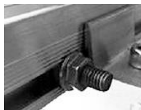
Dispositif anti-glissement en bas de pente
